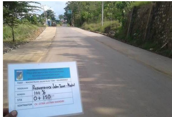
Ruas Towi - Kolonadale (DAU)
